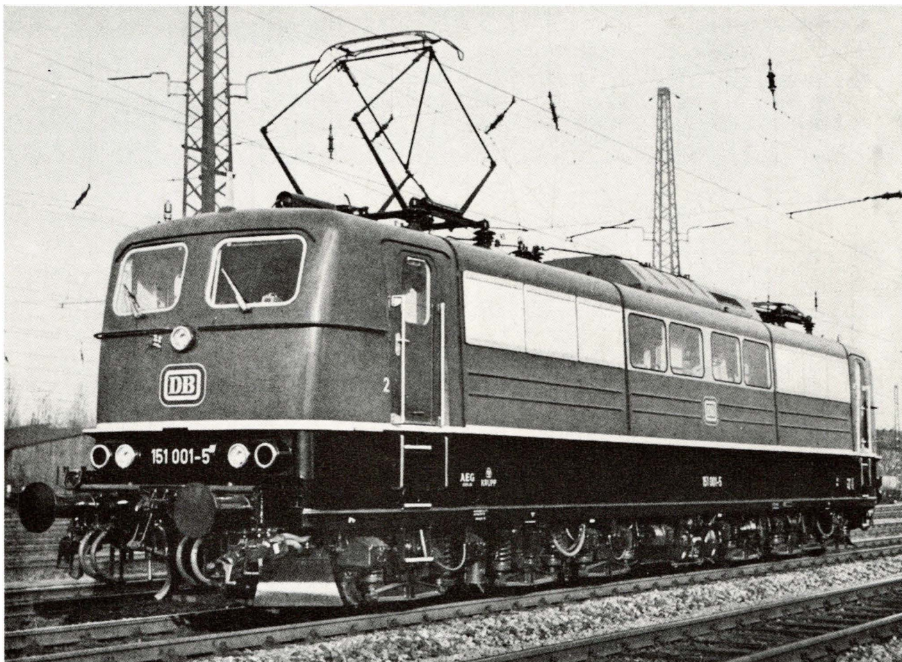
DB's 6-akslede standard-elektrolokomotiv til svære godstog, type 150, er blevet viderudviklet til en type, som nu seriebygges, og som kaldes type 151.
